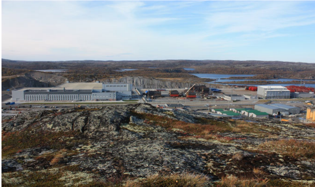
Рис. 2.2. Расположение площадки долговременного хранения и ландшафт Центра по обращению с радиоактивными отходами Сайда-Губа / Fig. 2.2. Location of the long-term storage site and landscape of the Radioactive Waste Management Center of Saida Bay
