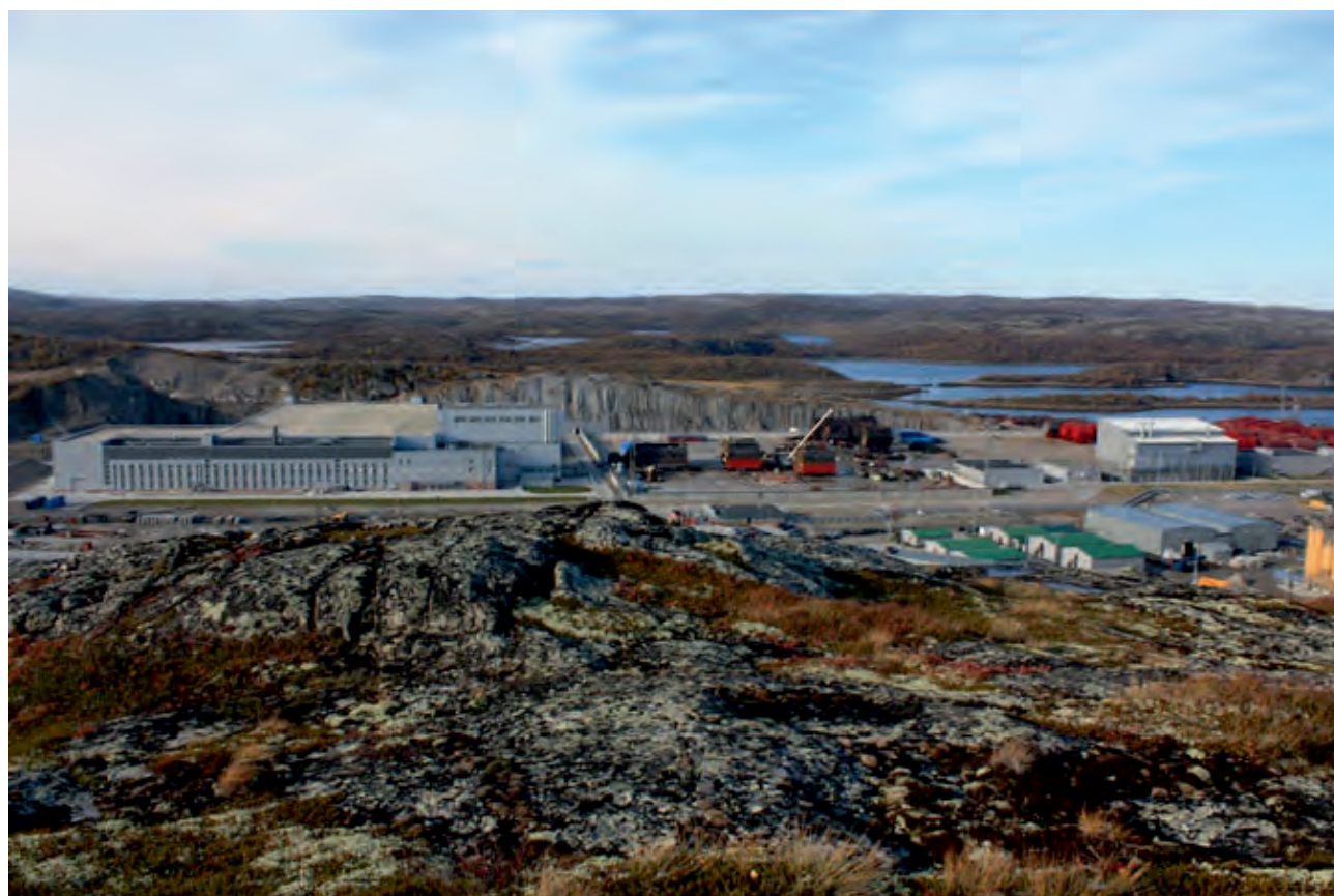
Рис. 2.2. «Региональный центр по обращению с радиоактивными отходами Сайда-Губа» СЗЦ «СевРАО» (фото из открытых источников)
