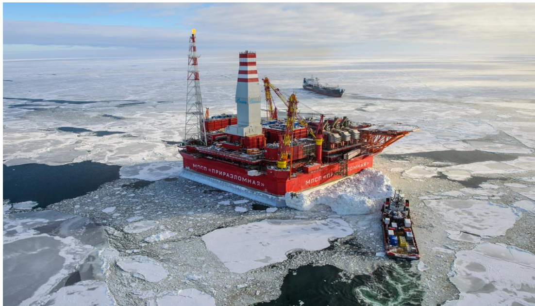
Рис. 3. Морская ледостойкая стационарная платформа «Приразломная» (russianpulse.ru) Fig. 3. Marine ice-resistant stationary platform «Prirazlomnaya» (russianpulse.ru)
